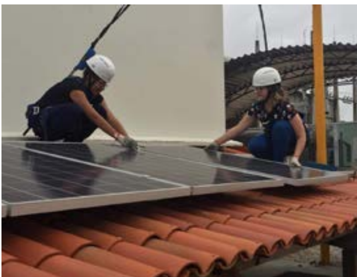
Técnica Eduarda Santos em campo na instalação de painéis solares
