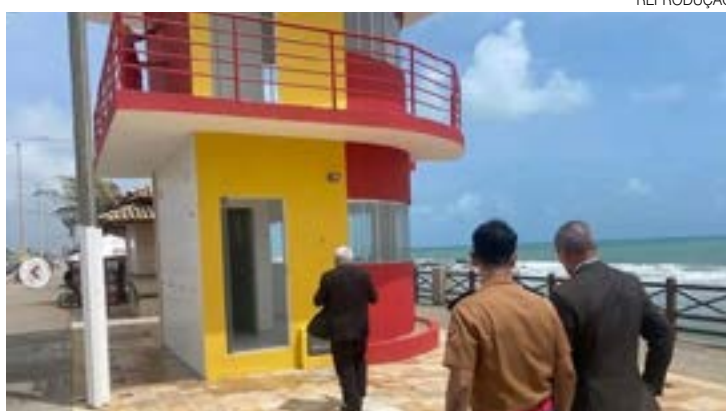
Cúpula da Segurança Pública inspeciona obras do posto guarda-vidas
