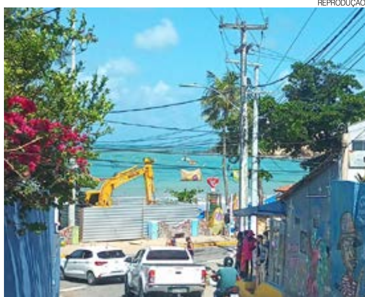
Já é possível ver máquinas e canteiro de obras na orla de Ponta Negra
