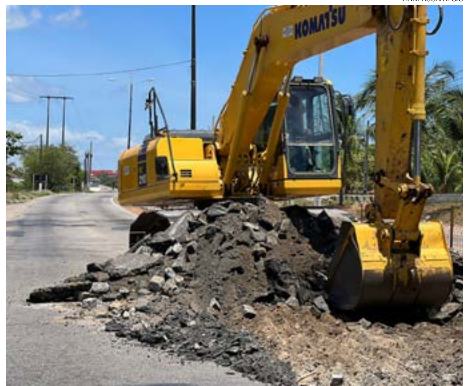
Maquinário da Prefeitura já está no local, realizando os primeiros serviços da obra
